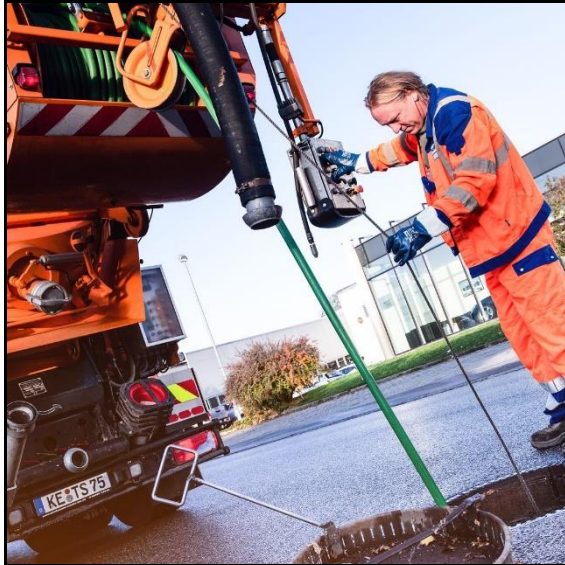
Spülwagen bei der Kanalreinigung (beispielhaft)
