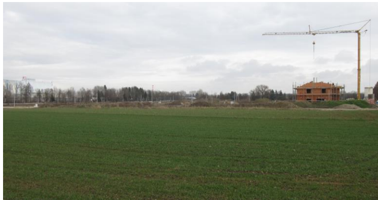
Im Gebiet des neuen Bebauungsplanes „Heckenweg“ wurde mit dem Bau des ersten Einfamilienhauses begonnen.
