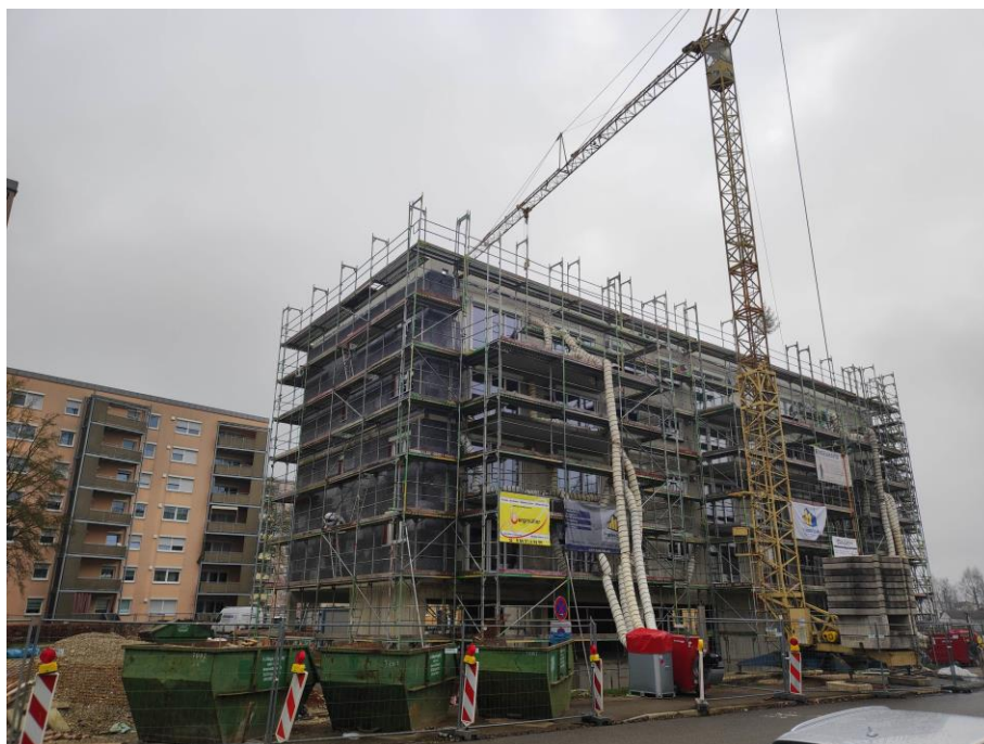
In der Richard-Wagner-Straße wurde mit dem Bau eines Mehrfamilienwohnhauses mit Tiefgarage begonnen.
