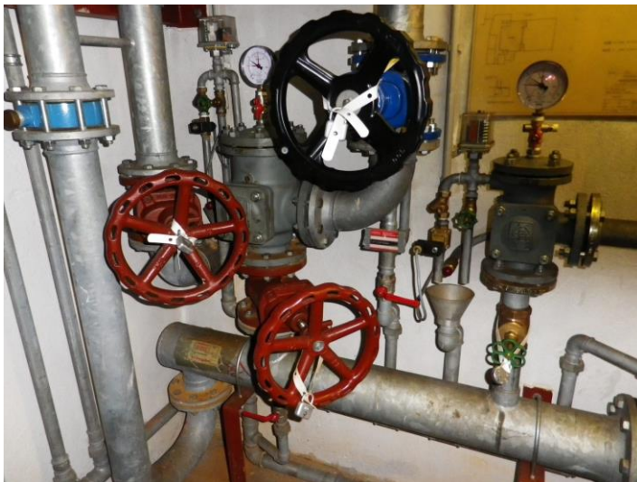
Abbildung 197: Sprinkleranlage
