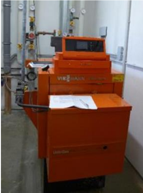
Abbildung 216: Gas-Heizkessel Burgwehr
