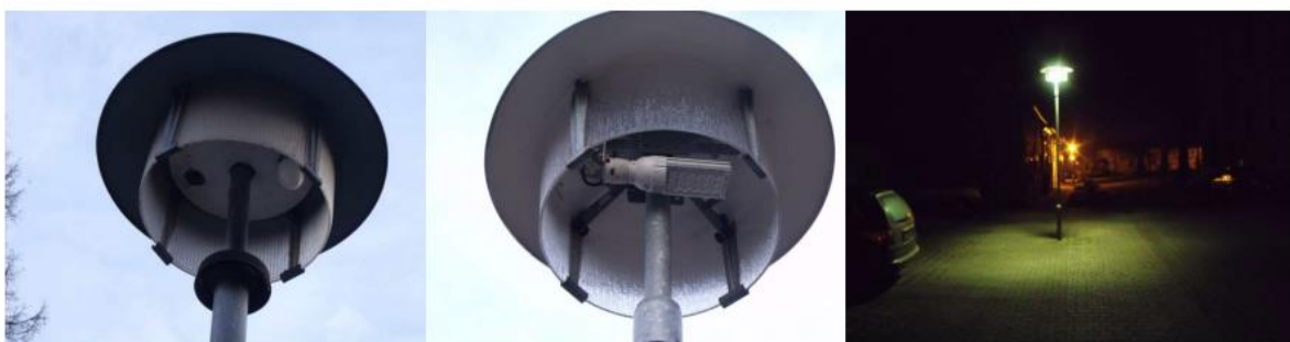
Abbildung 75: Einfache Umrüstung einer konventionellen Straßenlampe auf LED
