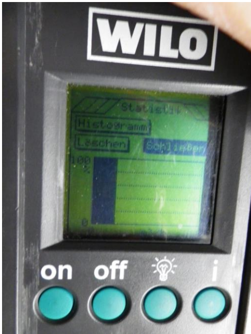
Abbildung 184: Auslesung Umwälzpumpen
