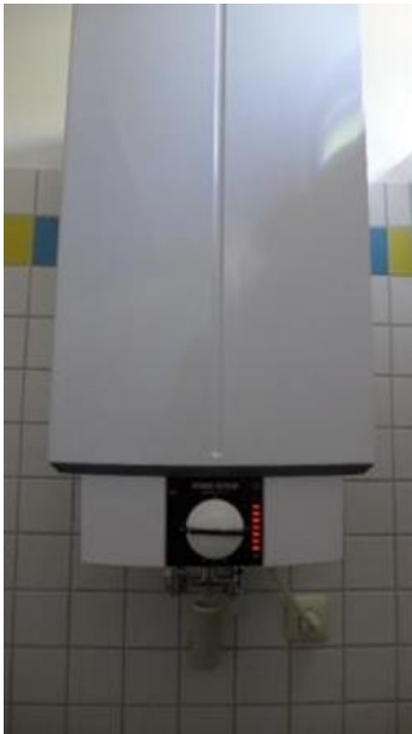
Abbildung 228: Warmwasserbereiter Stiebel Eltron SHD 30 S
