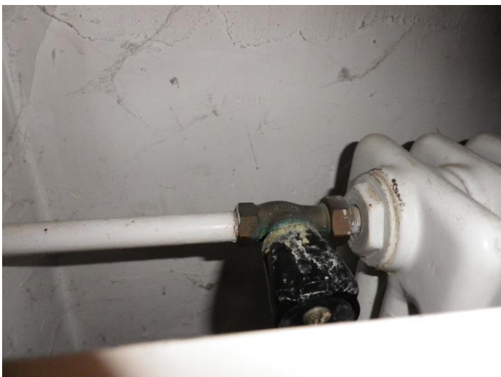
Abbildung 187: Heizkörperregelung ohne Thermostatventil
