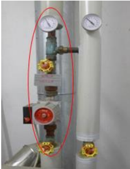
Abbildung 218: Ungedämmte Wärmeverteilungsleitung
