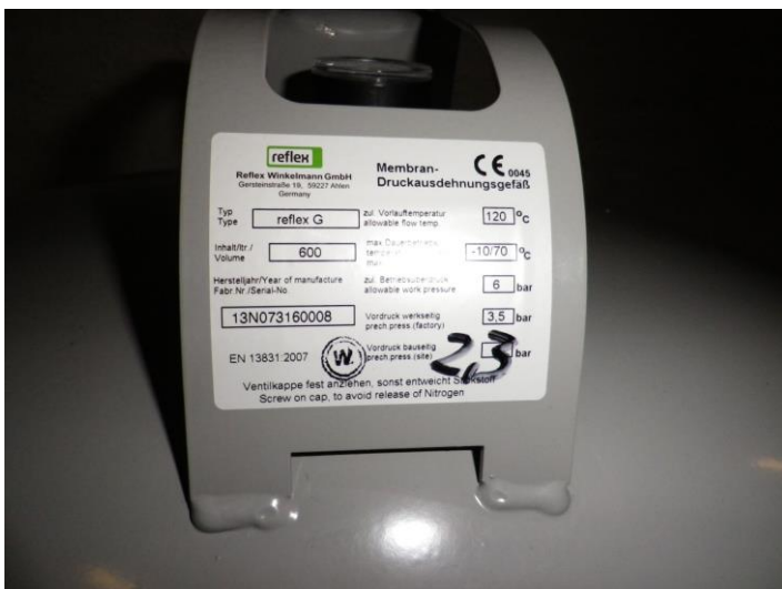
Abbildung 178: Typenschild Ausdehnungsgefäß
