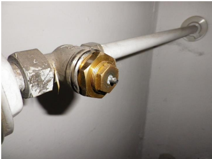
Abbildung 186: Heizkörperventil, nicht voreinstellbar
