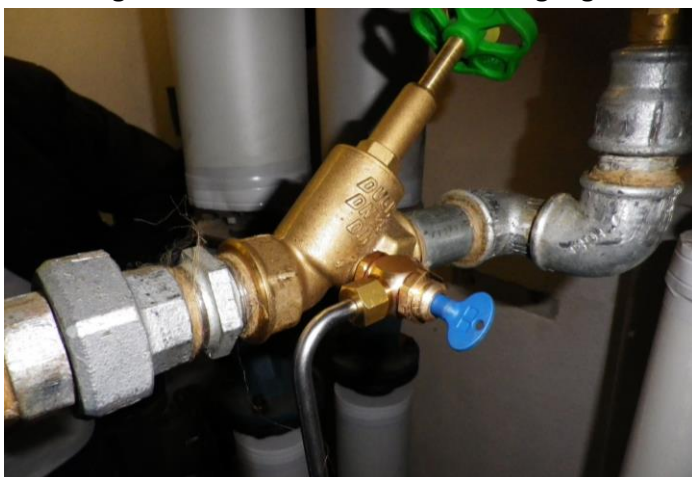
Abbildung 193: Prüfhahn Trinkwasserversorgung
