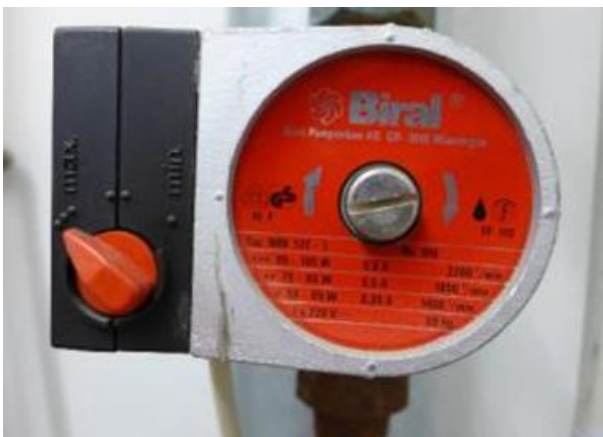
Abbildung 217: Umwälzpumpe
