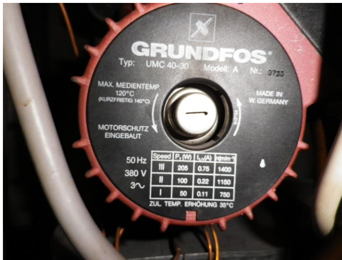
Abbildung 188: Ungeregelte Heizungspumpe ohne Frequenzumrichter
