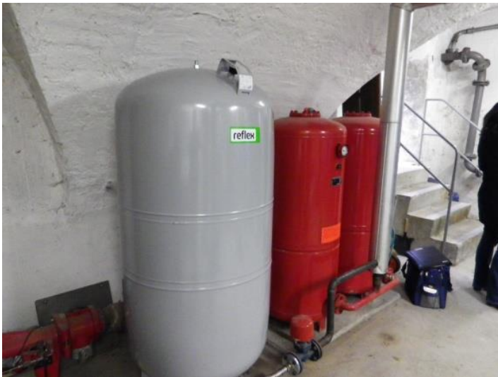
Abbildung 177: Druckhaltestation
