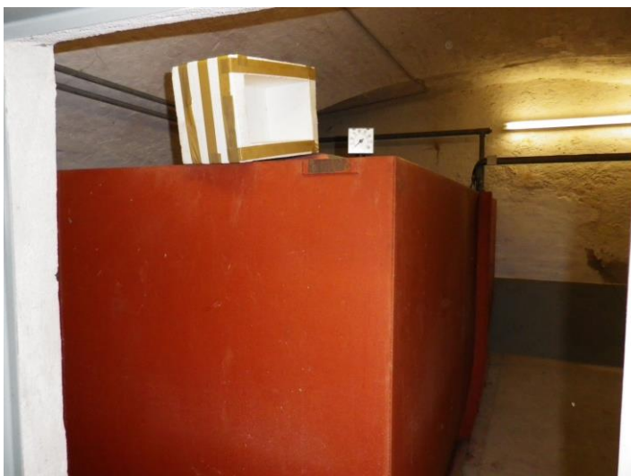
Abbildung 190: Kellergeschweißter Öltank
