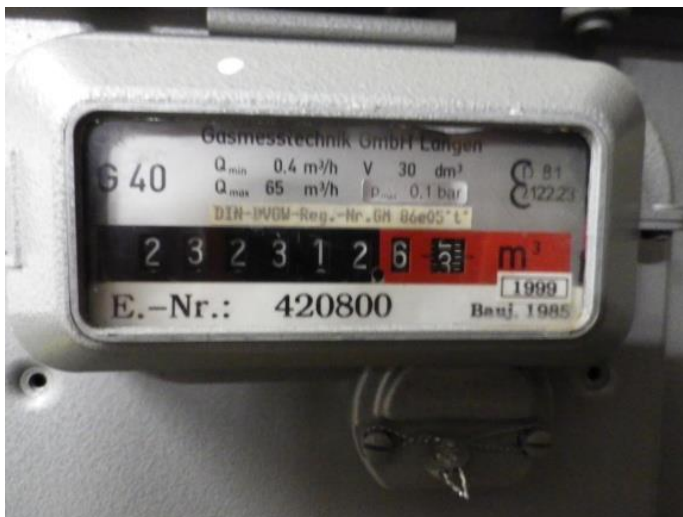
Abbildung 175: Gaszähler
