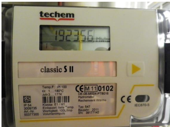
Abbildung 176: Haupt-Wärmemengenzähler
