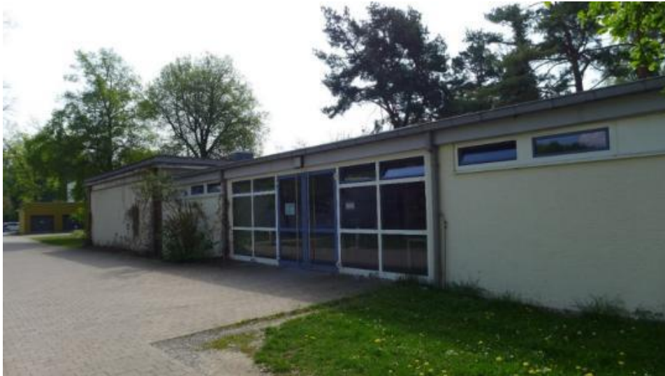
Abbildung 221: Pavillon der Mittelschule am Parkbad
